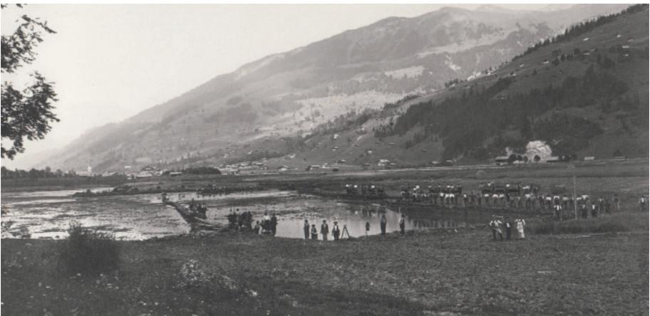
*Der Bau Lenkersee, zur Entsumpfung des Landwirtschaftslandes, wurde 1910 bis 1916 in reiner Handarbeit ausgeführt. Rechts auf dem Bild der helle Flecken ist ein grosser Steinbruch aus welchem die Steine zur Verbauung und Begradigung der Simme abgebaut und abtransportiert wurden.*
